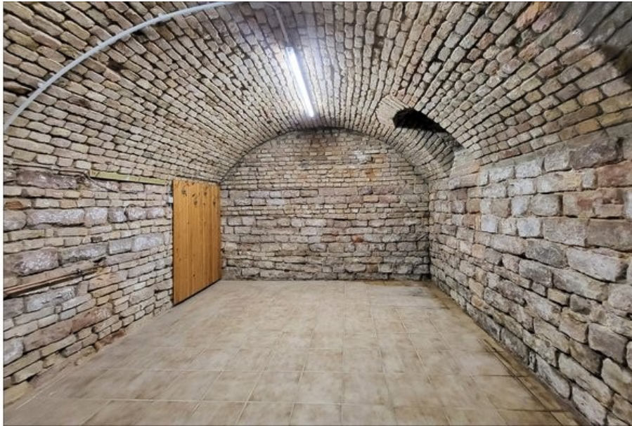
Gewölbekeller mit freigelegten Wänden und Gewölbe
