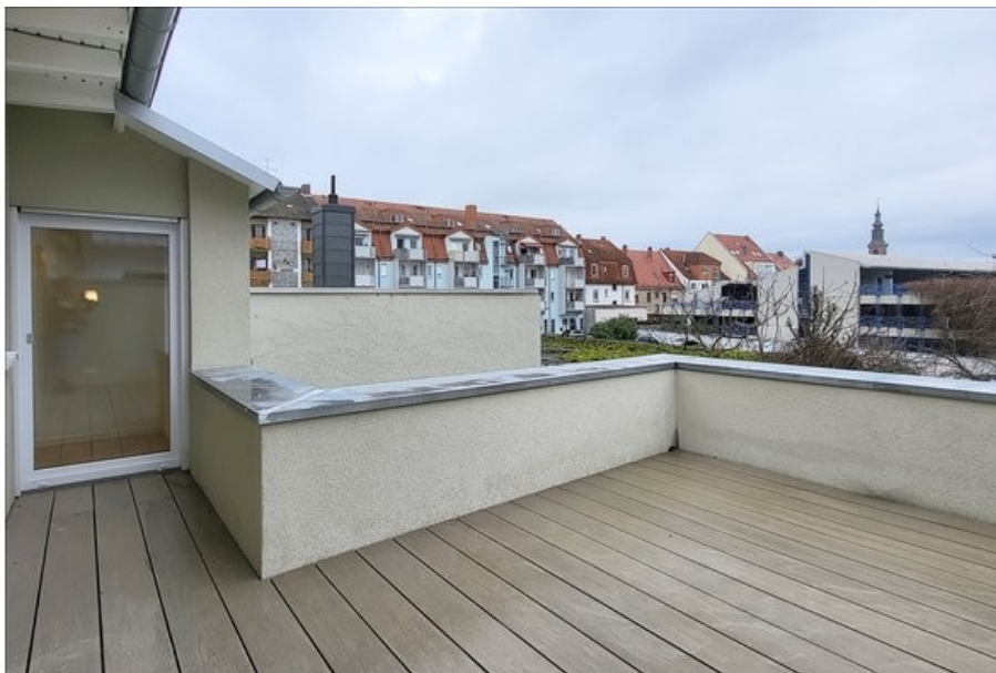
Dachterasse mit zwei Zugängen
