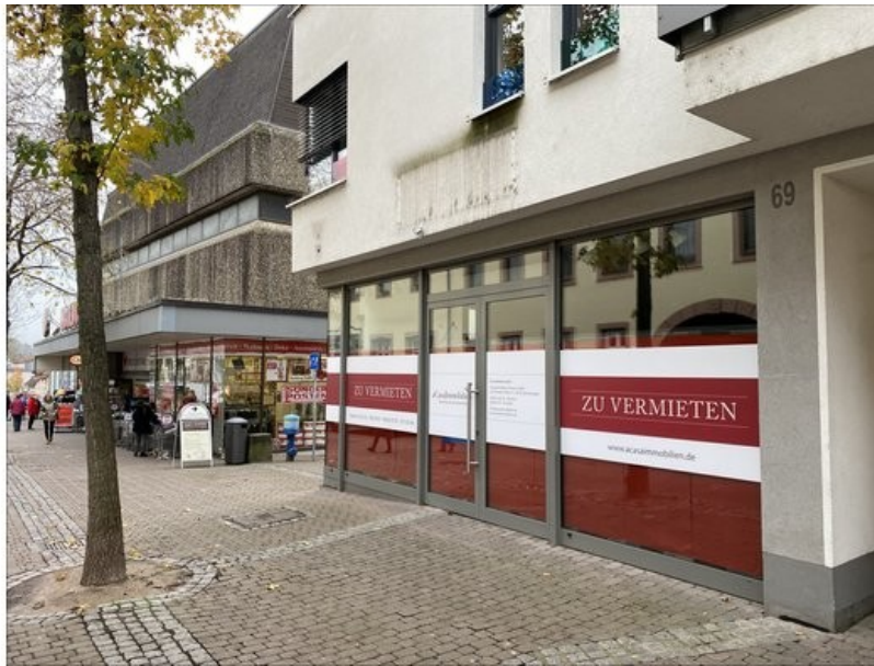
Straßenfront mit großer Schaufensterfläche
