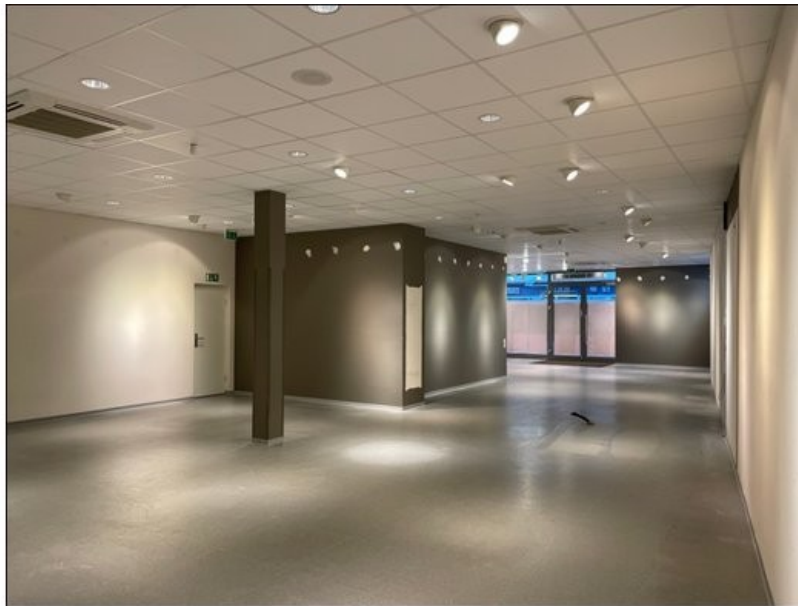
Gesamtfläche des Ladens
